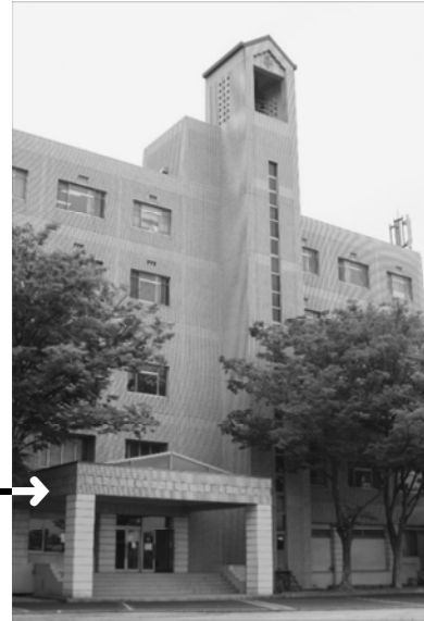
D棟と英語の詩がはめ込まれている南玄関ポーチ
